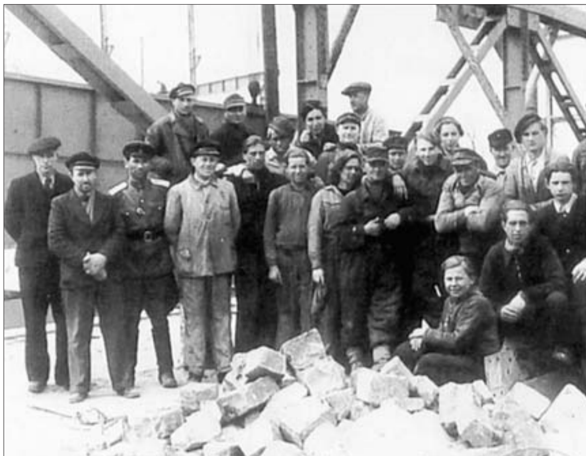
Einst größter Arbeitgeber der Stadt Ribnitz, nach dem Krieg auf der Demontage-Liste: das Flugzeugwerk. Der Besitzer Walther Bachmann versuchte das Werk wieder zurück zu erhalten, um hier eine zivile Produktion aufzubauen. Dies misslang. Unter dem 17. April 1948 wurde die Enteignung bestätigt. Repros: OZ
